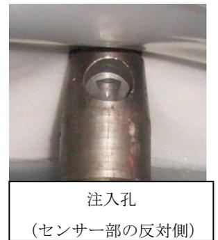
FCPピンをトンネル覆工コンクリート天端にセット
